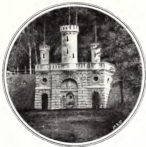
Vorbau des Hochbehälters im Sternwald.
